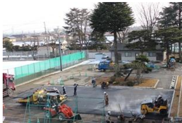
(1月16日) 昇降口前は アスファルトが 固められています
