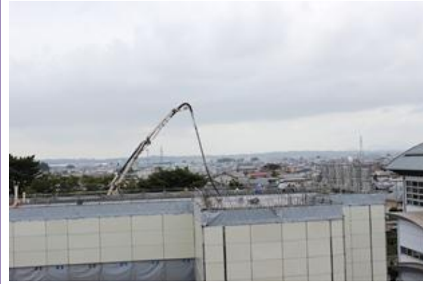
(9月25日) 屋根にコンクリート を流し込み
