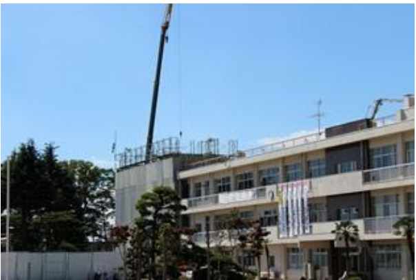
(9月27日) 管理棟玄関側より
