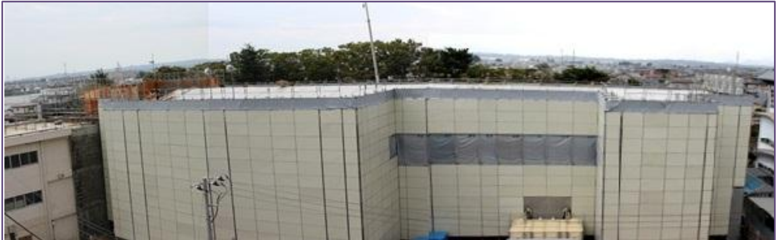
(2013.10.3)屋根のコンクリート打設後の様子
