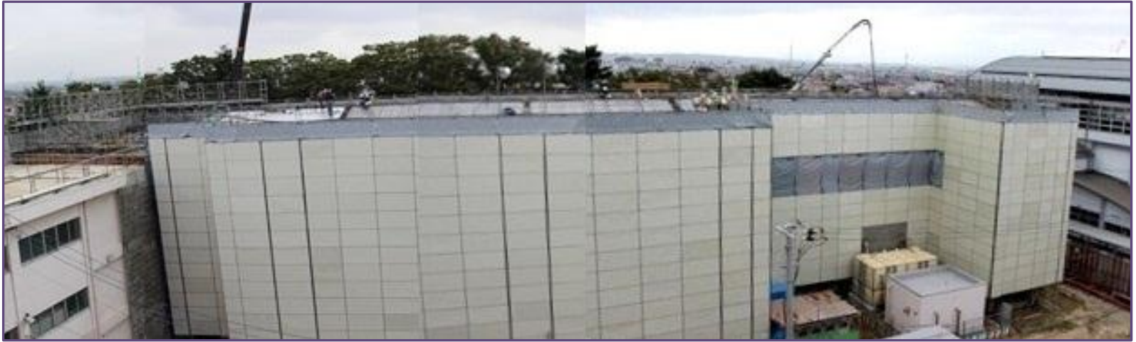
(2013.9.25)屋根の配筋作業の様子
