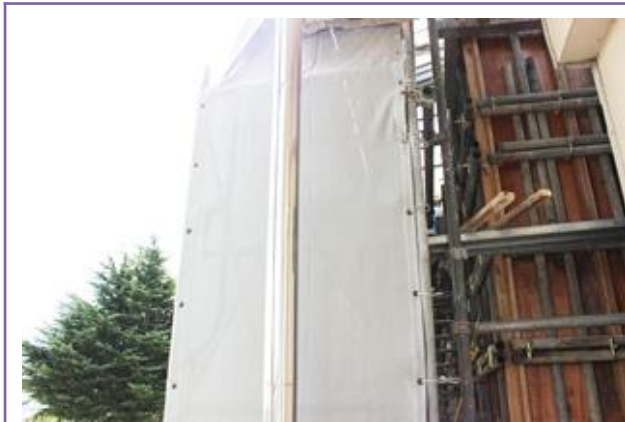
(9月30日) 管理棟との 接地部分①
