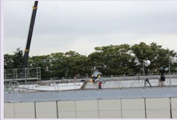
(9月25日) 屋根部分の 作業の様子② (配筋溶接など)
