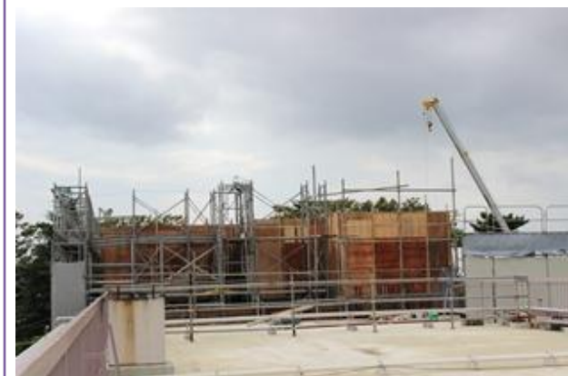
(10月3日) 吹抜け部分の枠が 組み立てられて きてます
