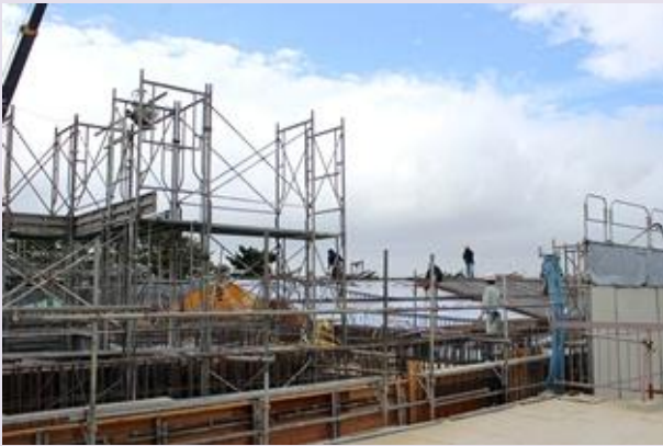
(9月25日) 屋根部分の 作業の様子①
