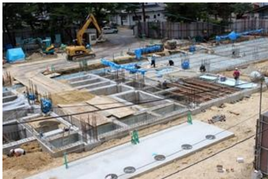
(6月21日) 着々と埋戻しが 進んでいます
