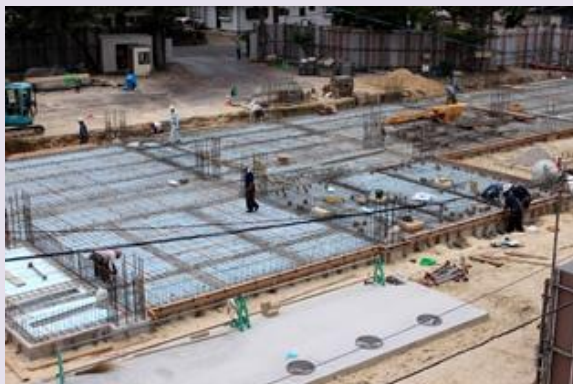
(6月26日) 埋戻した上に鉄筋が 敷かれました
