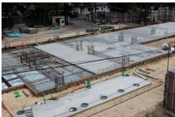
(6月28日) 綺麗にコンクリート 打設されていきます
