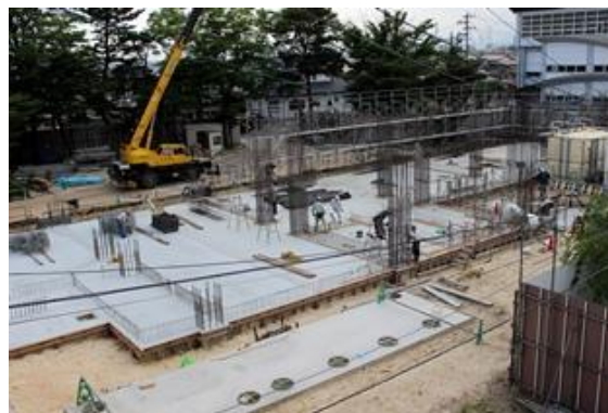
(7月1日) 足場の組み立てが 始まりました
