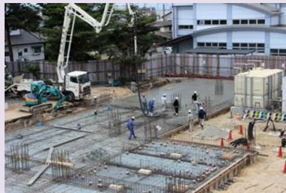
(6月27日) 土間コンクリート 打設が始まりました
