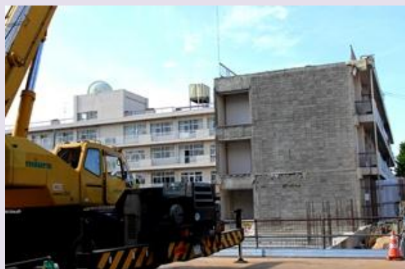
(6月17日) 正門側からも 基礎工事が様子 が窺えるように なってきました
