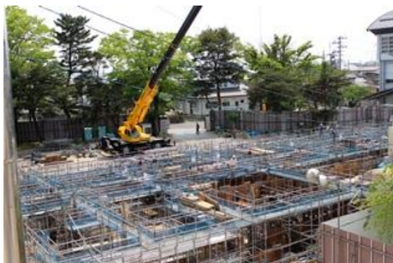
(5月27日) 積んでいった板は 壁として設置されて いるようです
