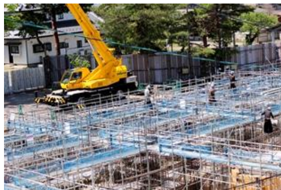
(5月17日) 足場での作業も 始まりました
