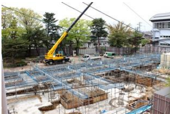
(5月16日) 足場が次々と 組まれていきます。
