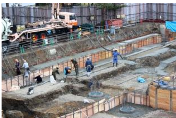
(4月30日) コンクリートが注入 されています。
