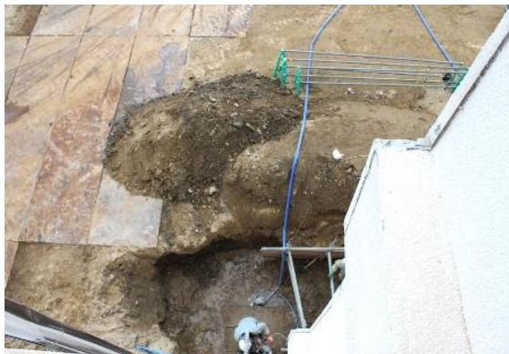
(2月20日) 事務棟昇降口脇が 掘削されました。
