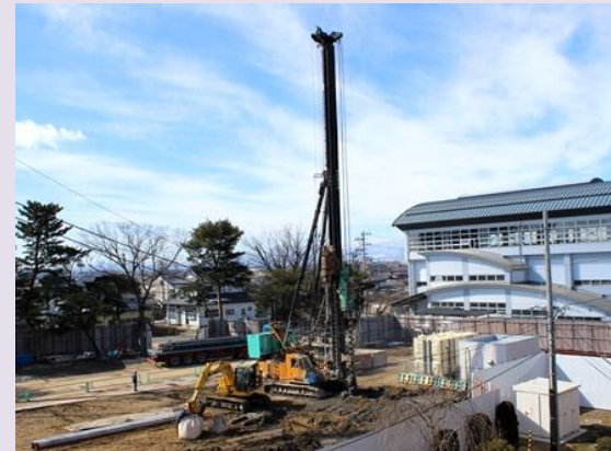
(3月4日) 温室付近を掘削中。
