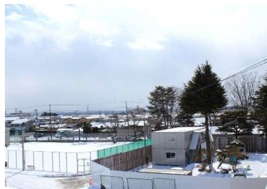
(2月25日) プレハブ設置完了。
