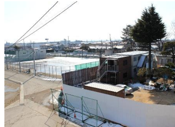
(2月28日) プレハブ設置完了。
