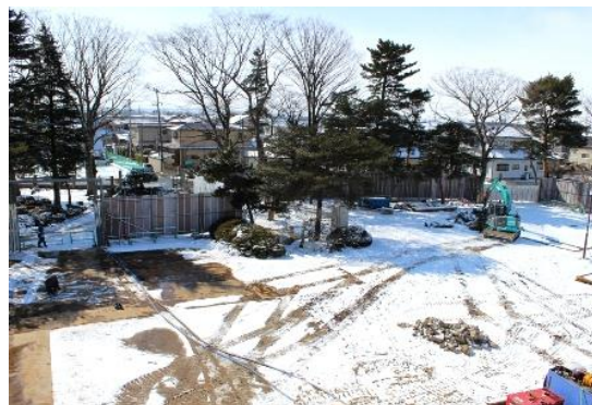
(2月21日) 植込み撤去後を 片付けています。
