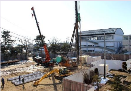
(2月28日) 掘削準備。
