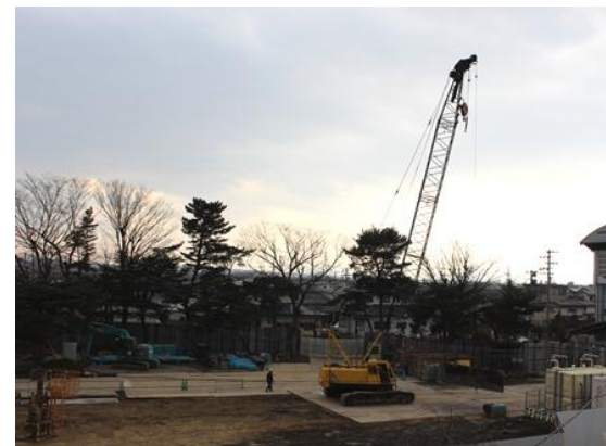
(3月6日) 鉄板が次々と 敷き詰められて いきます。
