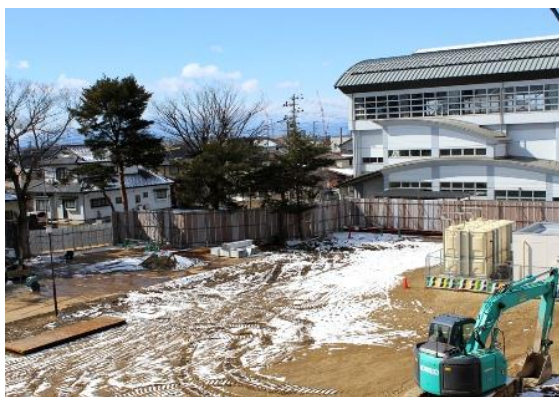
(2月22日) 南側に鉄板が 敷かれ始めました。
